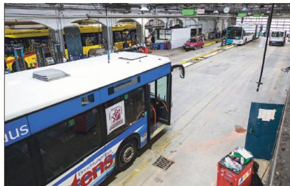
Im jetzigen Depot ist nicht genügend Platz für die erforderlichen Starkstromanschlüsse.
